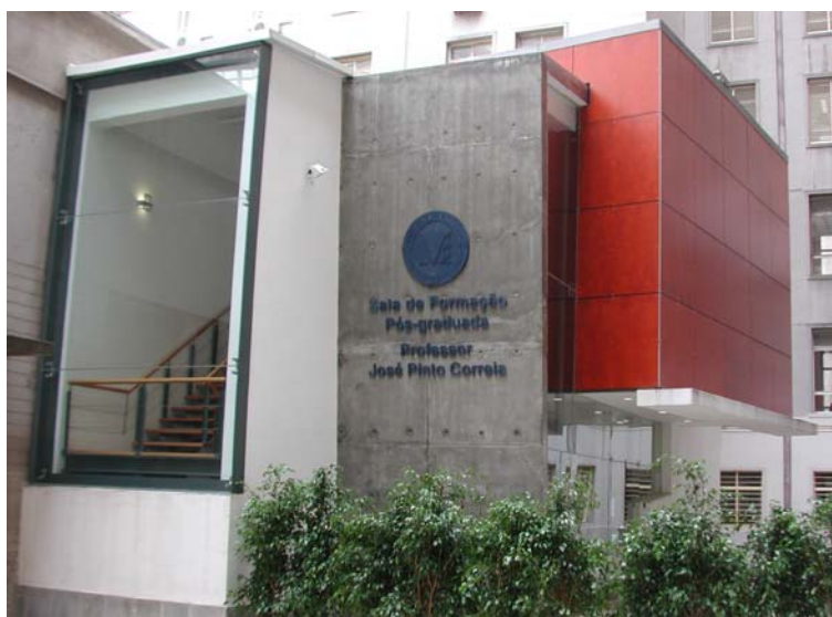
Fotografia 15 – Perspectiva do edifício para a Formação Pós-Graduada (“Sala de Formação Pós-Graduada Professor Pinto Correia”) onde está a funcionar transitoriamente o Instituto de Formação Avançada.
